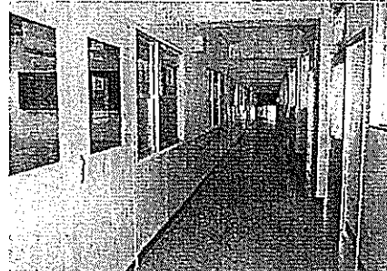
完成した2階教室・廊下
