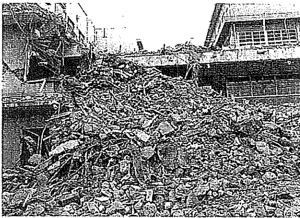
取壊し・解体工事が進む
