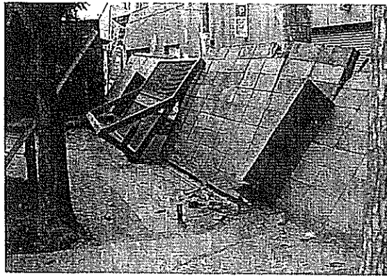
学校の校門前（ブロック塀倒壊）
