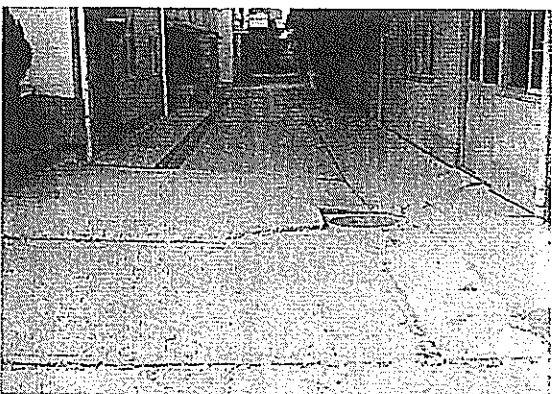
第1実習棟と第2実習棟間通路 陥没・隆起
