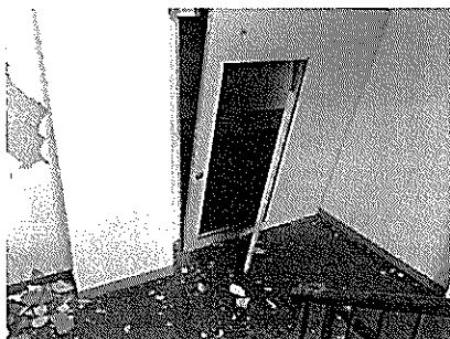
本館階段防火扉
